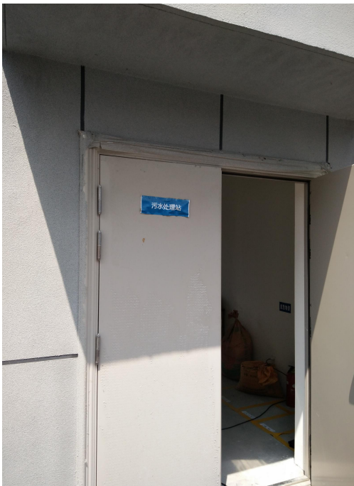
⑦ 污水处理站
